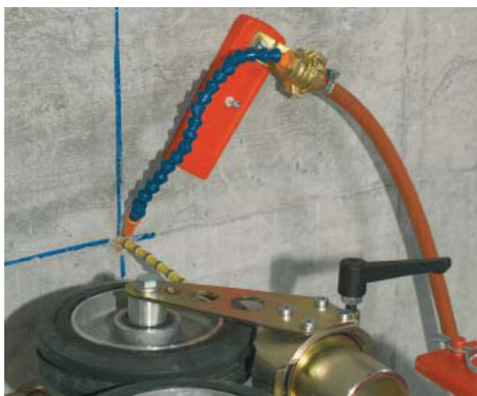
冷却水ノズルを装着
