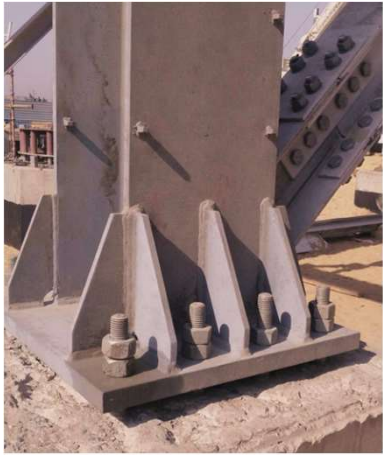
Baseplate Kolom dan Balok Baja
